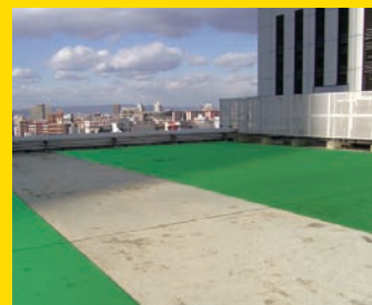
屋上防水シート
